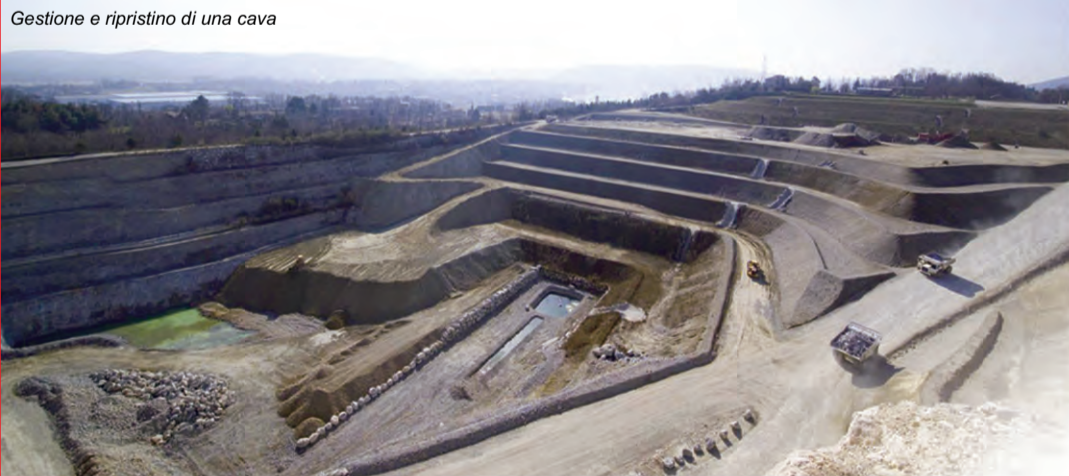
Gestione e ripristino di una cava
