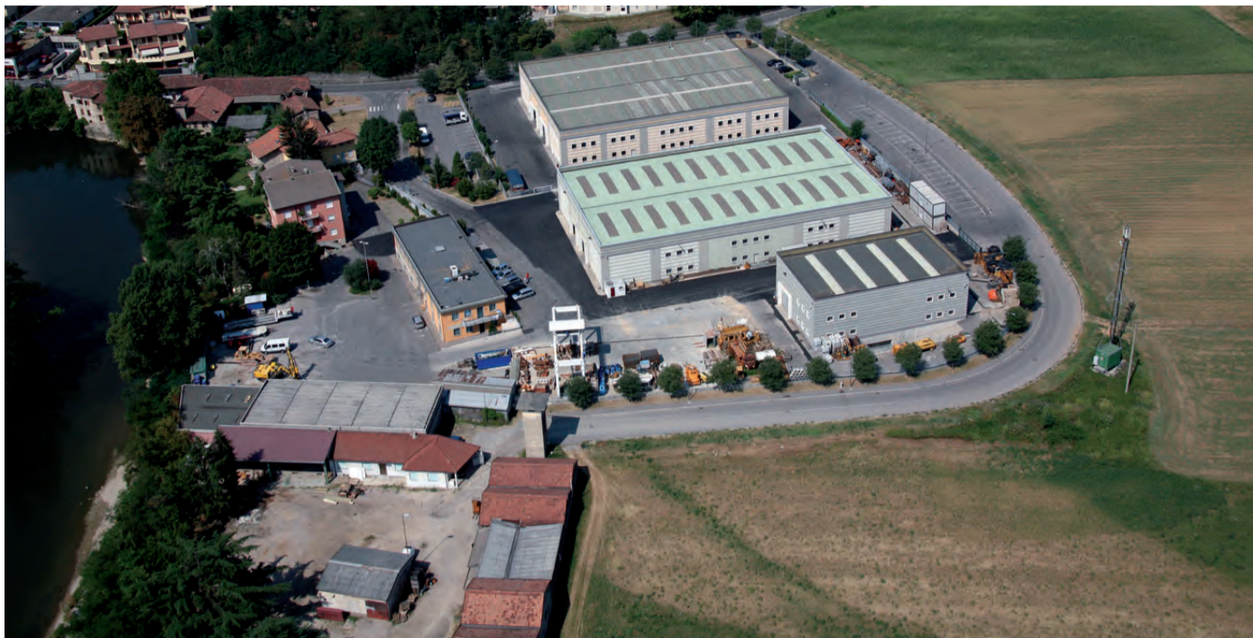
La sede della Edilmac in via Trento a Gorle
